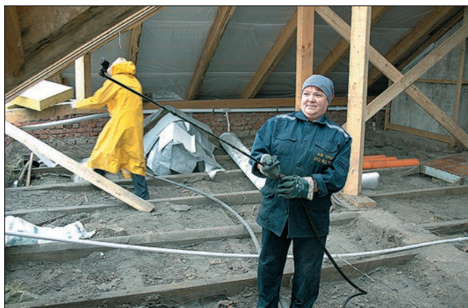
Пропитчица Ф.Н. Хасанова пропитывает деревянные конструкции кровли жилого дома
