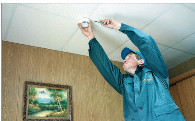
Электромонтёр М.В. Лялько устанавливает датчик пожарной сигнализации
