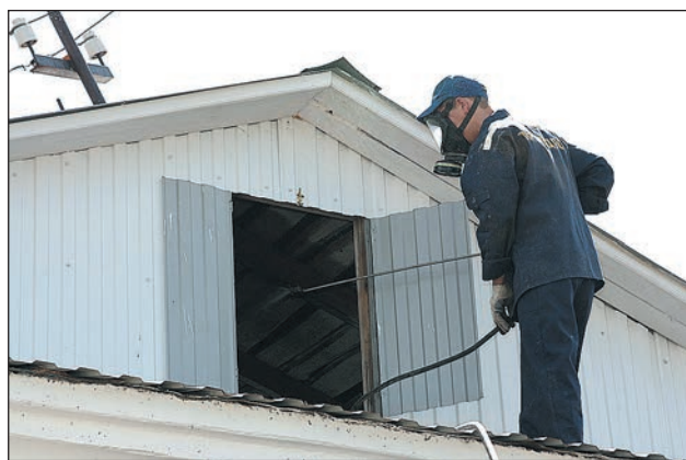
Электромонтёр П.Г. Журавлёв пропитывает деревянные конструкции здания магазина в с. Поручиково
