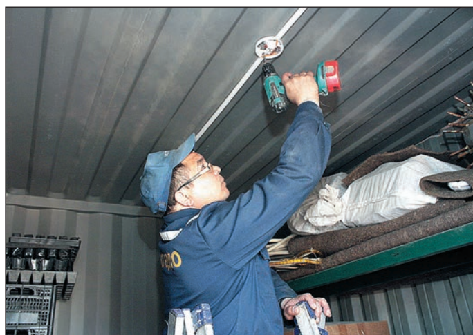
Электрик А.А. Хафизов устанавливает датчик пожарной сигнализации
