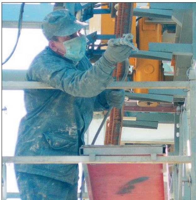
↑ Нанесение огнезащитной краски на металлические конструкции
