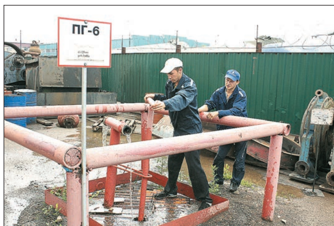
Печник И.В. Хусаинов и печник-контролёр Э.З. Гайнутдин проверяют пожарный гидрант
