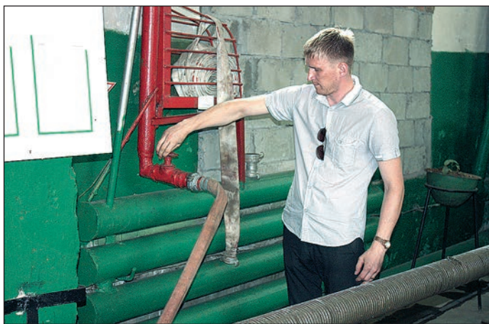
Мастер Р.Ф. Латыпов проверяет пожарный гидрант на водоотдачу
