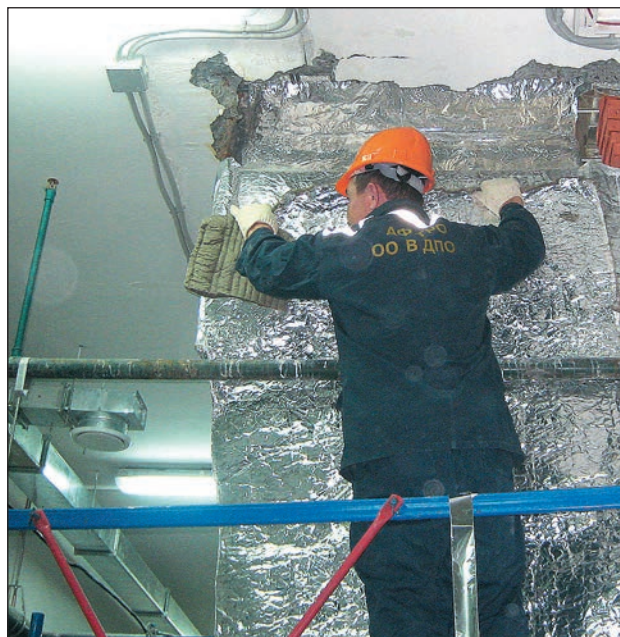
↑ Защита от огня воздуховодов специальной термозащитной фольгой
