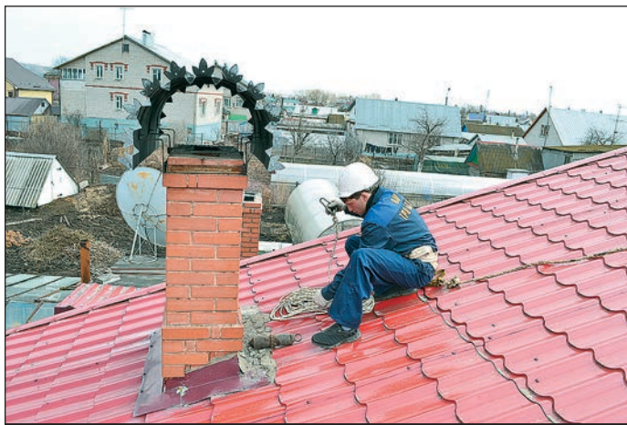
Печник-контролёр З.З. Гайнуллин готовится чистить дымоход
