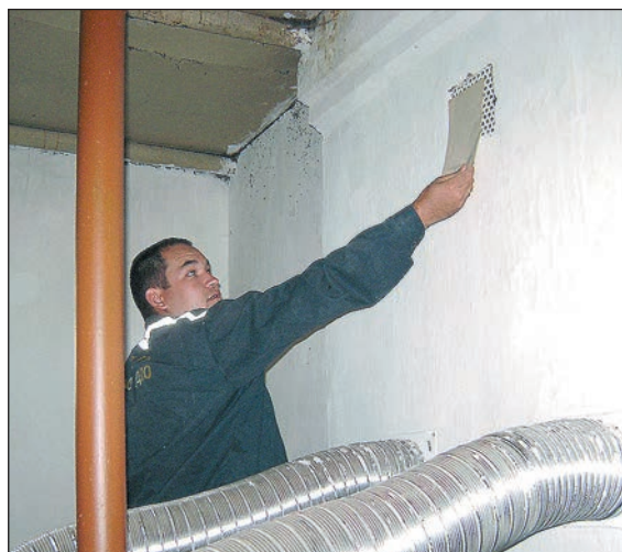
↑ Гилязов Р.В. проверяет тягу вентиляции
